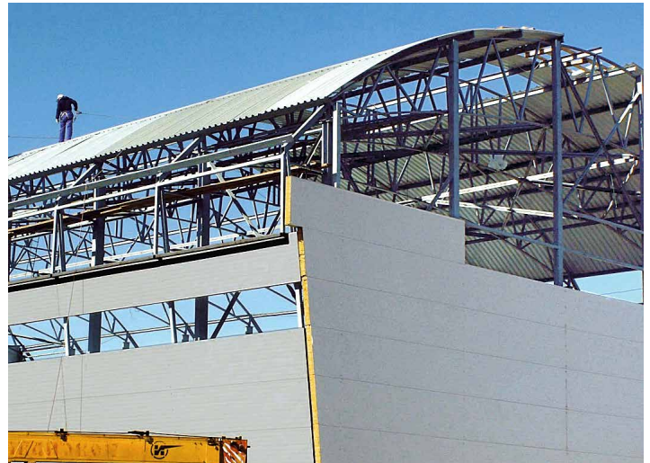
Монтаж спортивного комплекса с кровлей из продольно-гнутого профиля (Казахстан, г. Астана)
